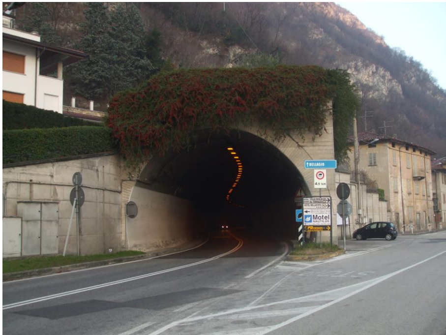
Valmadrera loc. Parè, galleria
