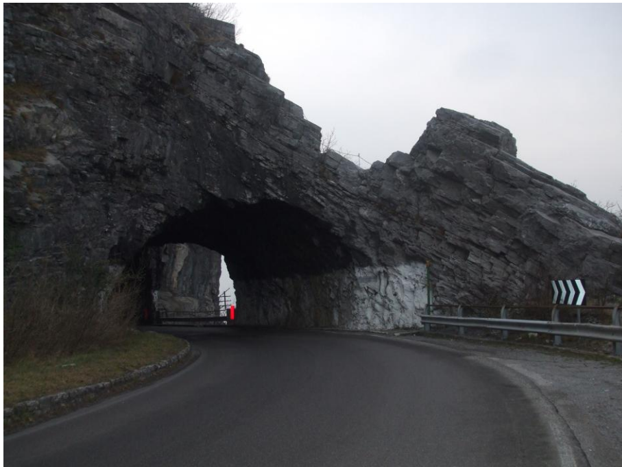
Galleria tra Bellano e Varenna
